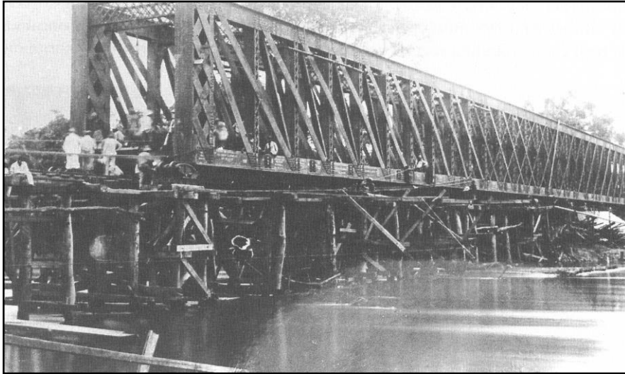
Mise en place du pont sur l'Inkisi (Longueur 100 mètres, poids 400 tonnes). Année 1897.
