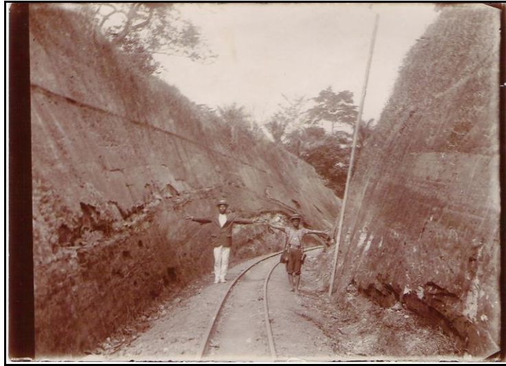
Le faible écartement des voies et l'importance des travaux de déblais.
