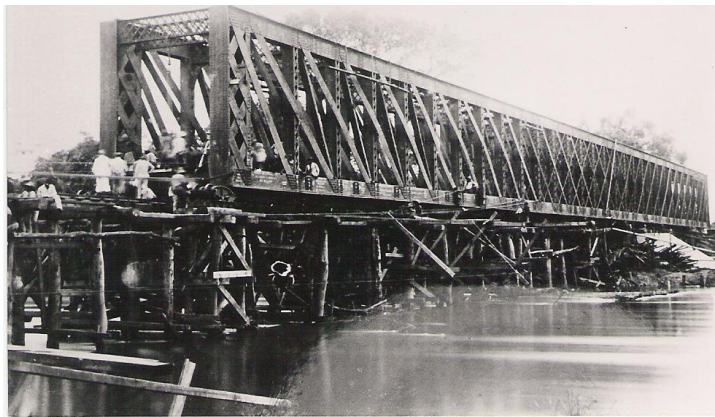
Type de travaux des ingénieurs, le pont de l'Inkisi, plus de 100 m, 450 tonnes. Conception et construction (1896).
