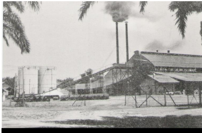
Usine pilote de Mongana sur la rive gauche du fleuve Congo
